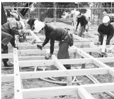
長野市で仮設木造住宅の建設も
